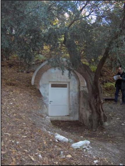
Tenía un caudal que oscilaba entre 2 y 25 l/s según referencias históricas y se utilizaba para abastecimiento y riego. Actualmente está seco. El agua se capta directamente en el manantial al que se accede por una escalera de obra. Surge en las proximidades del contacto entre las calizas de algas y calcarenitas blancas y las margas blancas del Mioceno medio (Complejo Caótico Subbético).
