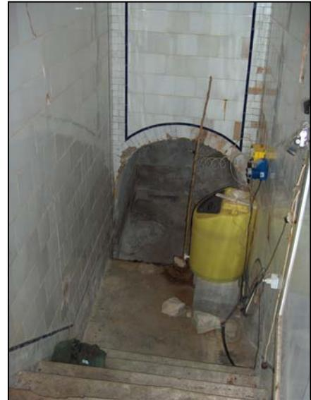
**3. " Sondeo de Arca Cánava o Cañete" CA23052003 (203750009):** Capta materiales carbonatados de la M.A.S. 05.15 "Torres-Jimena". Tiene una profundidad real de 33 m aunque se perforaron 70 m (se rellenaron 37 m). Se sitúa a cota 695 m s.n.m.. Está entubado con tubería metálica de 350 mm de diámetro interior.
